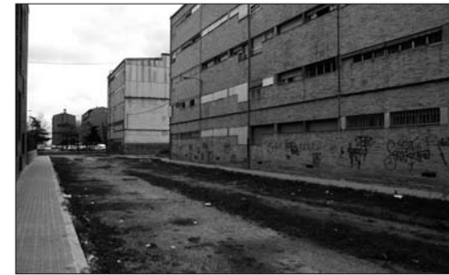
El exceso de espacio libre en los tejidos urbanos puede provocar su abandono (Fuencarral, Madrid).
