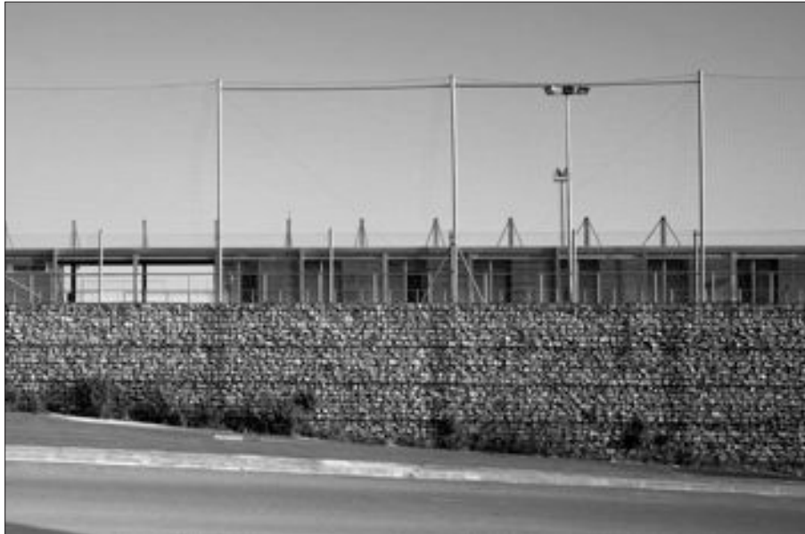
Acondicionamiento de taludes entre bancas horizontales con técnicas drenantes –gaviones– (Campo de fútbol en Vilassar de Dalt, Barcelona. Autor: Javier Belil Sans).
