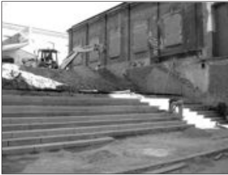
“Continuidad y conexión entre barrios: demoliciones selectivas para crear nuevos itinerarios en el recinto de Daoiz y Velarde, Madrid”
