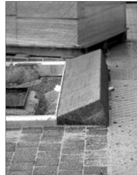
Durmiente de granito para impedir invasión del alcorque por parte de los vehículos en una calle de plataforma compartida; encuentro entre pavimentos de adoquín y losa de cemento (Espacios Libres de Daoiz y Velarde, Madrid).
